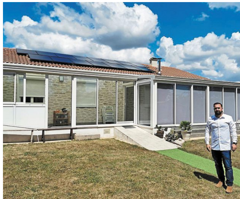
L'un des deux logements équipés de l'armoire optimisant la consommation d'énergie générée par les panneaux photovoltaïques.
