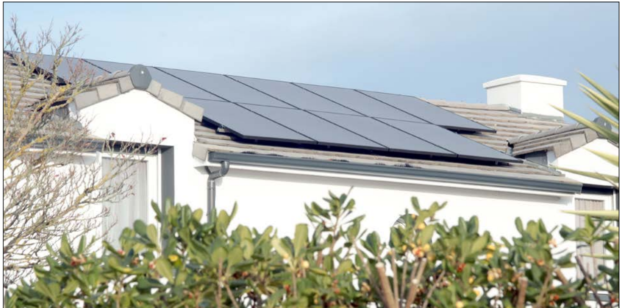
Clef de voûte du système, les panneaux solaires. Un équipement de haute technologie pour un rendement assuré.
